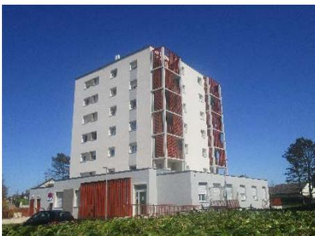
Au-delà de la reprise des enduits des façades, consécutive aux travaux d'isolation et à la suppression de certaines fenêtres, la création d'un balcon rapporté au droit du séjour de chaque appartement des étages 2 à 6 et la dépose de l'escalier extérieur en pignon nord, donnent une nouvelle esthétique au bâtiment.
